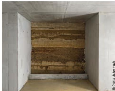
« C'est un chantier unique, au bilan carbone très bas. Très peu de camions sont entrés dans le chantier ou en sont sortis. 80 % des matériaux ont été sourcés sur place, dans le béton concassé de l'ancien chai et dans la terre excavée en creusant un gigantesque trou de 50 mètres de long sur 12 mètres de profondeur. C'est ce qu'on appelle la terre coulée ou le béton de site. C'est une technique ancestrale qui consiste à couler la terre à la façon d'un béton de ciment. »
